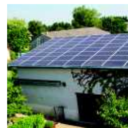
toiture en panneaux solaires
