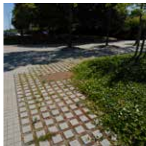
pavés joints perméables
