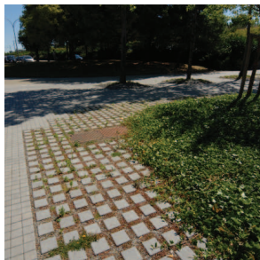
pavés joints perméables
