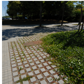
pavés joints perméables
