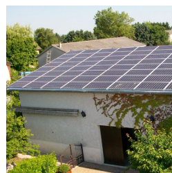
toiture en panneaux solaires
