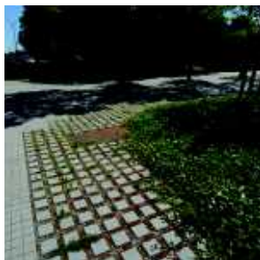
pavés joints perméables
