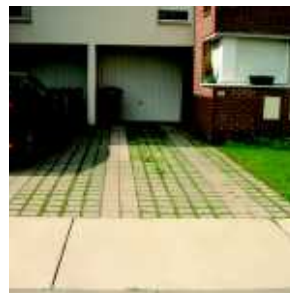
pavés béton et pavés béton à joints engazonnés
