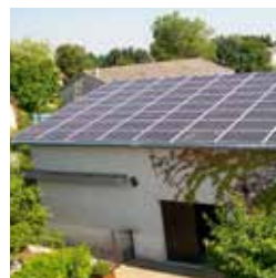
toiture en panneaux solaires
