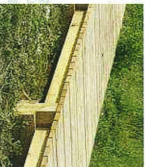
Platelage en acacia et structure chêne. (HQE)
