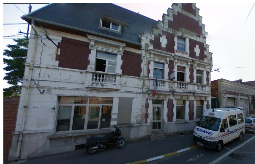
L'ancien commissariat de police
