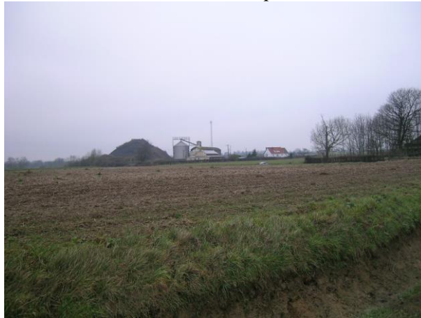
Vue sur le silo UNEAL depuis la RD94 :
