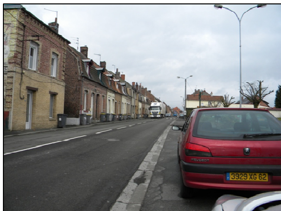
Entrée ouest – rue de Saint-Venant
