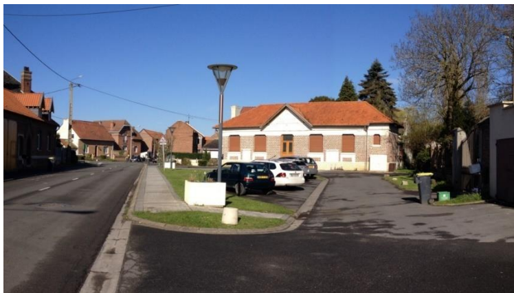
Place du 11 novembre – parking en enrobé
