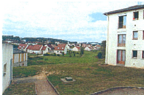
Les collectifs qui dominent la vallée de la Logette Les espaces collectifs sont peu qualifiés. Une action pourrait être engagée pour revaloriser leurs abords, délimiter les espaces publics et privés, planter et ménager des chemins vers la vallée.
