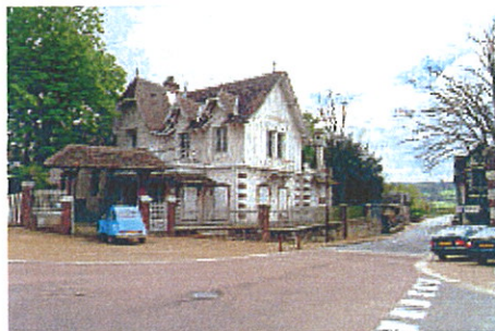
Logement directeur de l'usine Abadie
