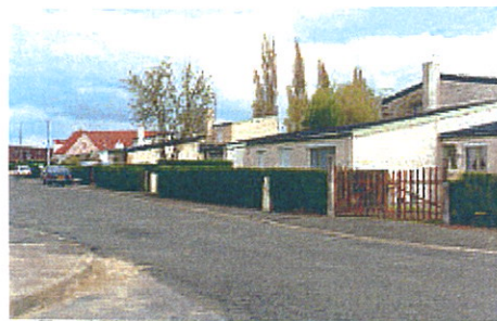
Logements groupés rue des Sources
