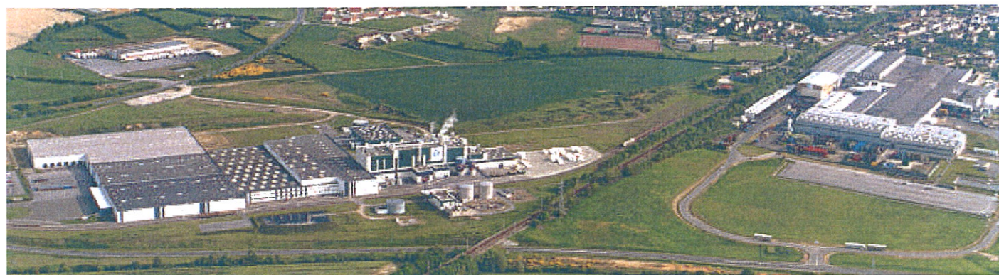
Vue aérienne des sites industriels : à gauche l'usine SCA, à droite l'usine THYSSENKRUPP SOFEDIT
