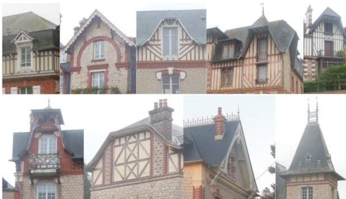
Exemples de couvertures et de façades (source : diagnostic de l'AVAP)
