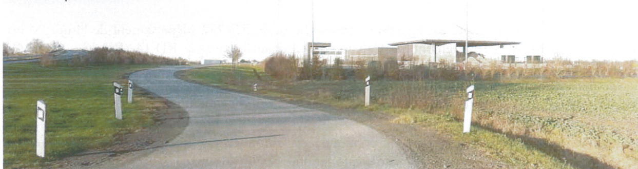
Centre d'exploitation autoroutière
