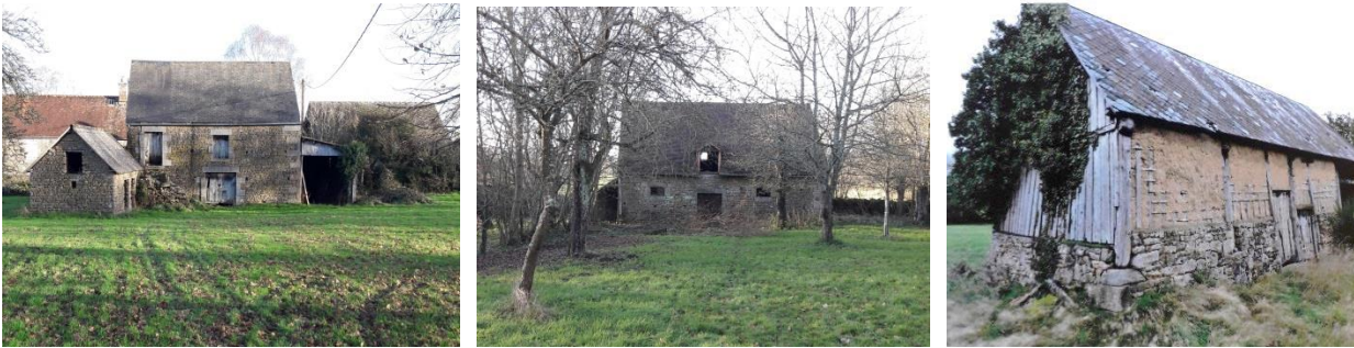
Exemples de bâtiments retenus pour possibilité de changement de destination
