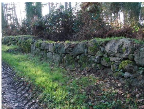
Muret de pierres près de la chapelle Saint-Sauveur
