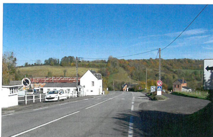
Vue de l'entrée du village depuis la RD 438
