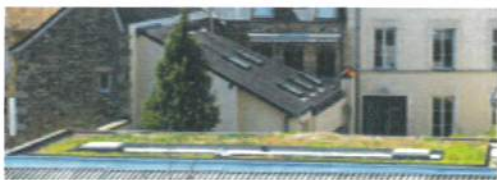
Toit stockant végétalisé
