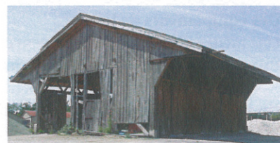
Ancienne gare de marchandise
