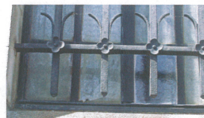
Détail d'une grille de fenêtre en fer forgé
