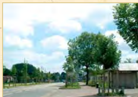
Réalisation d'un projet de traverse d'agglomération
