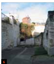
6 Entrée d'une des carrières souterraines dans le Nord-Ouest de Vineuil.
