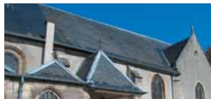
Toiture en ardoises (église).
