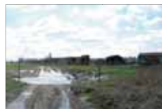
Vue depuis l'arrière de la scierie vers le site de stockage des planches.
