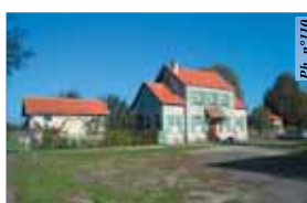
Ancienne gare depuis le plateau à proximité des activités de la scierie.
