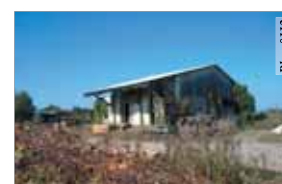
Hangars de stockage désaffecté.
