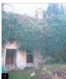
7 Habitat troglodytique à la suite de l'exploitation de matériaux.
