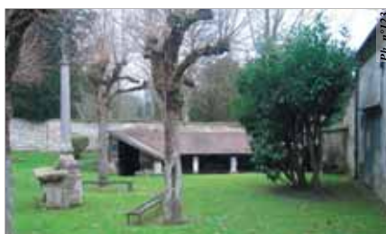
Lavoir réhabilité permettant sa bonne conservation au bord de la RD924 dans Saint-Firmin.
