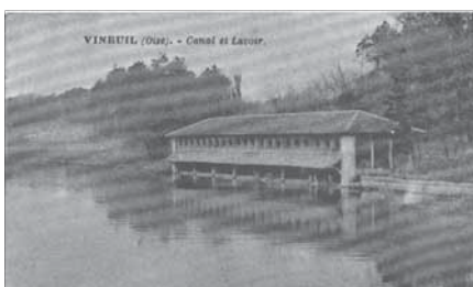
Ancien lavoir sur la commune de Vineuil ; sa disparition montre la fragilité de ce petit patrimoine lorsqu'il n'est plus d'usage....
