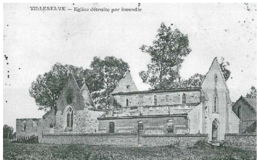
Figure 7 : Eglise de VILLESELVE détruite par un incendie au siècle dernier
