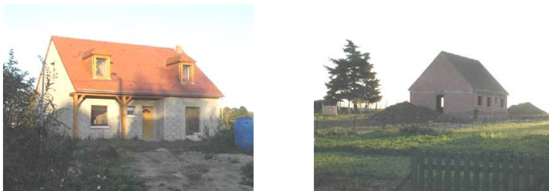
Figure 85 : Représentation des maisons en cours de construction
