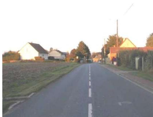
1. Rupture du bâti
