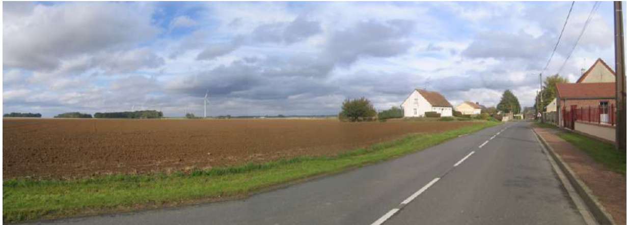
Figure 27: Vue panoramique de l'entrée Sud-ouest de la commune depuis la RD 91
