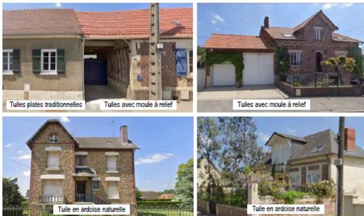
Illustrations des matériaux et aspects des toitures
