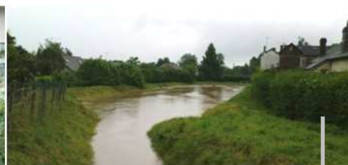
Bassin de Garifontaine 2
