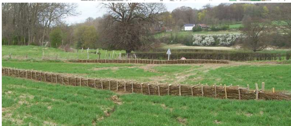
Barrages en fascine en fond de vallon
