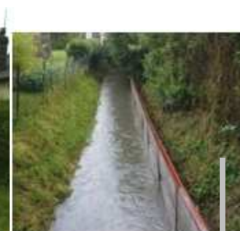
Fossé du Castel 3
