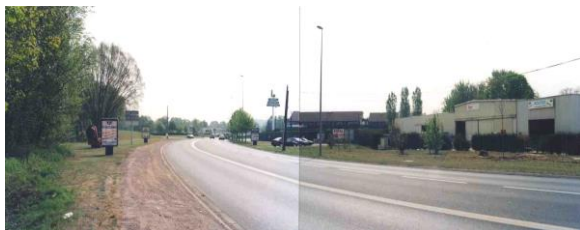
Entrée Ouest, depuis la RD 200
