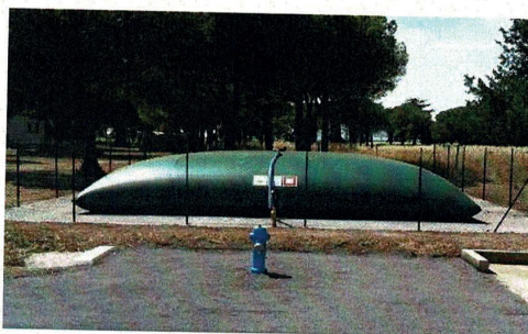
Illustration n°8 : Photographie d'une Réserve d'eau incendie souple.
