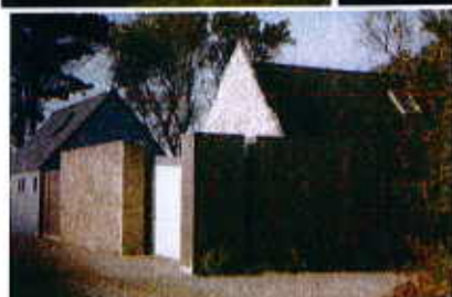
Maison en Bretagne, archi. Grégoire Maisondieu
