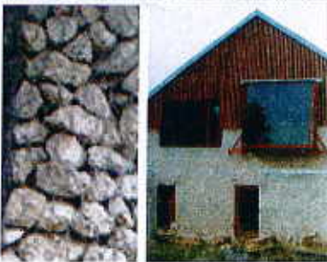
Matériaux : résilles métalliques pour plantes grimpantes, mur en gabion (caisson en treillage métal rempli de caillasse), pignon en moellon enduit à pierre vue et clins de bois associés aux fenêtres cadrées
