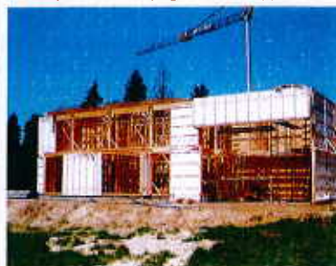
Chantier d'une maison à ossature bois
