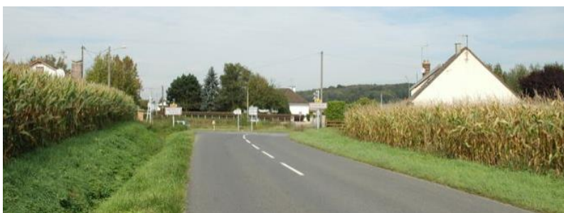
Figure 33 : Entrée sud-ouest par la RD41
