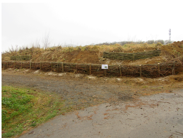
Fascines vivantes et empochement en cours de réalisation Chemin de la Montagne.
