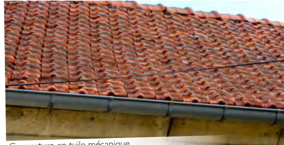
Couverture en tuile mécanique
