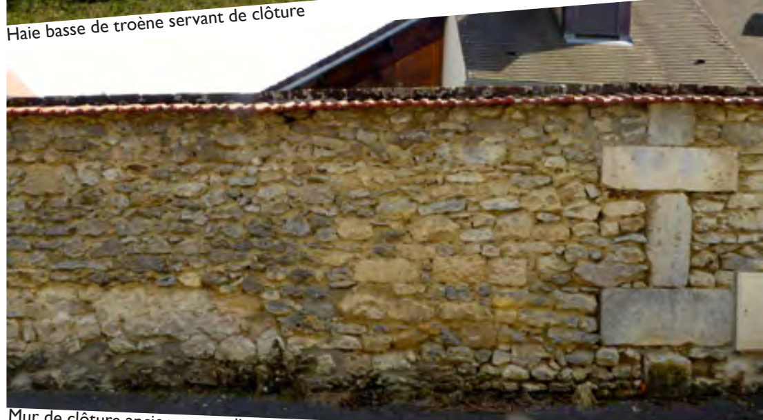
Mur de clôture ancien en moellon et pierre de taille calcaire
