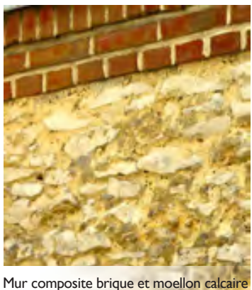
Mur composite brique et moellon calcaire
