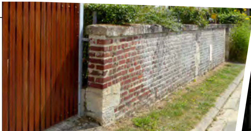
Mur bahut en brique et pierre
