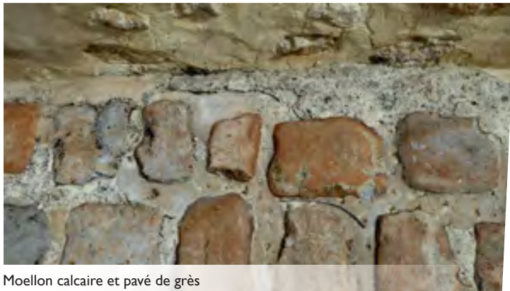
Mur composite calcaire, grès, enduit
