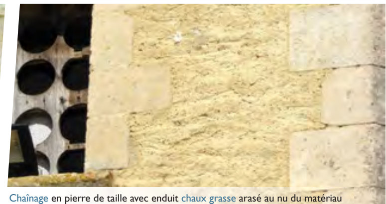
Chânage en pierre de taille avec enduit chaux grasse arasé au nu du matériau
