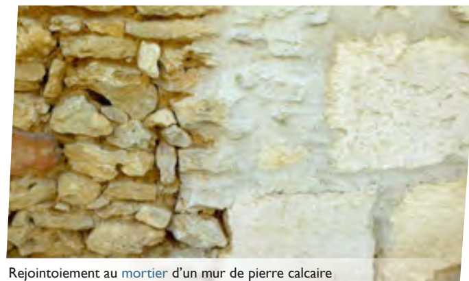
Rejointoiement au mortier d'un mur de pierre calcaire
