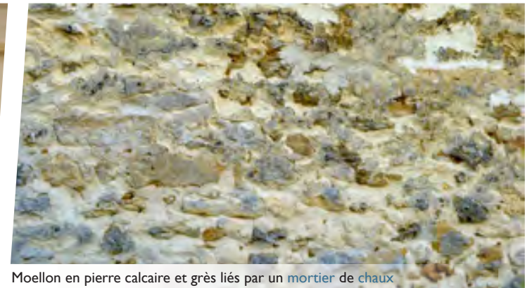
Moellon calcaire et grès - enduit - corniche en pierre de taille
