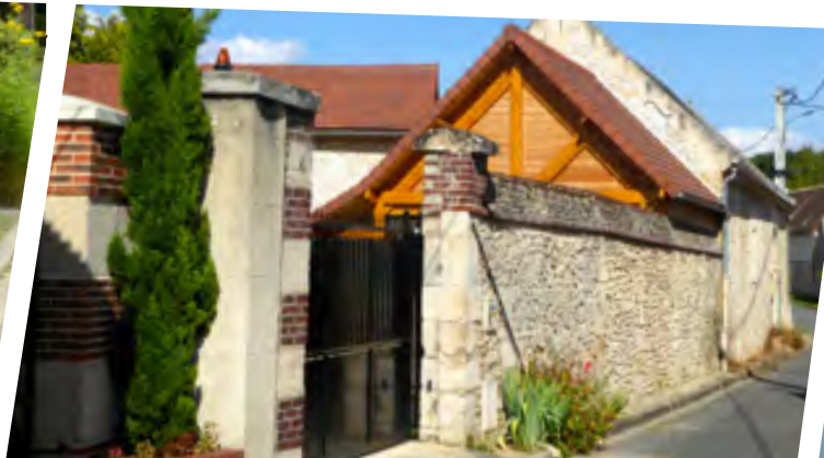
Clôture haute avec un portail en fer encadré de piles
