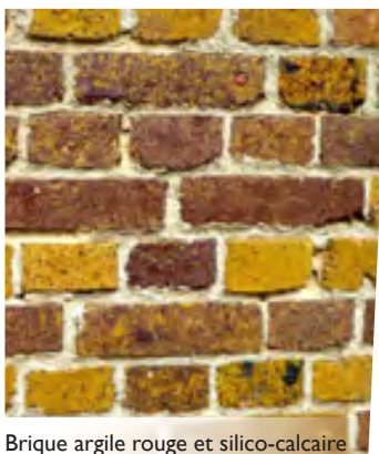
Brique argile rouge et silico-calcaire
