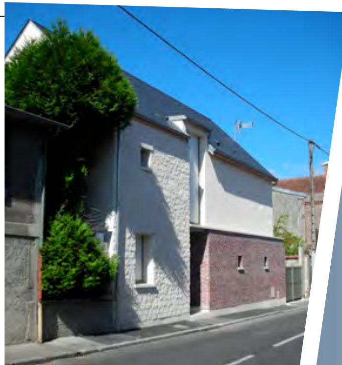
Front bâti contemporain en respect de l'alignement (Gouvieux) architecte : F.CAROLA
