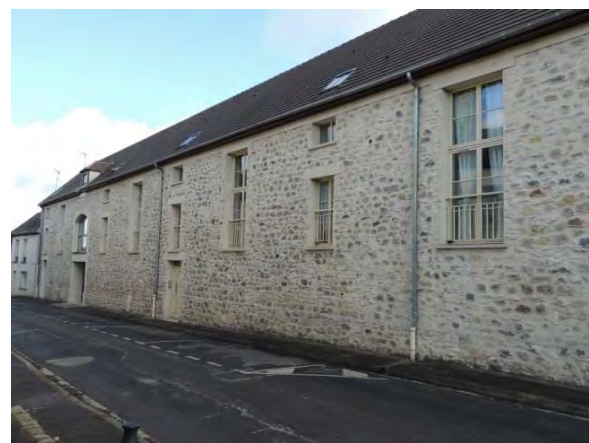
Logements dans un bâtiment de corps de ferme
