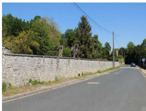
Mur de clôture Route d'Ermenonville
