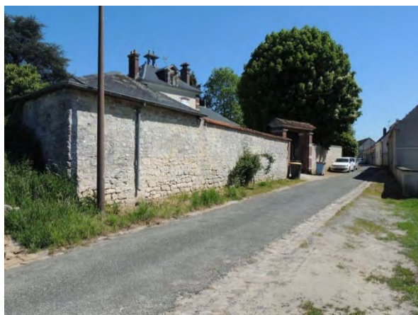
Mur de clôture Route du Péron
