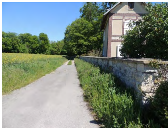
Mur de clôture du Domaine Saint-Sulpice
