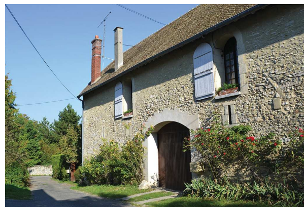
Construction en pierre de type R+1 avec pierre de taille comme ornement.
