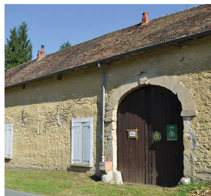
Façade en moellons et enduits ton pierre du Vexin.
