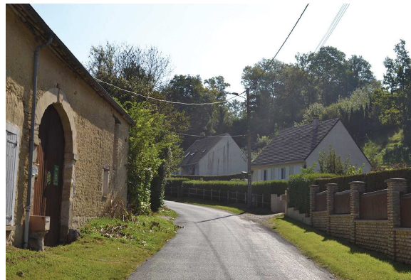
Alternance entre constructions anciennes et récentes sur la route de Montjavoult.
