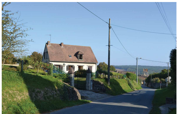
Construction en enduit ton pierre en léger retrait par rapport à la voie.
