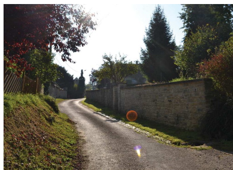
Autres murs en pierres plus récents.
