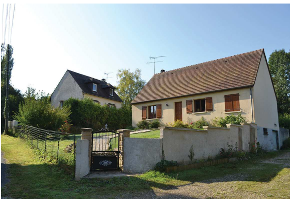
Constructions en enduit à deux pentes sur la rue Vieux Chemin de Boury.
