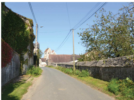
Murets en pierres, rue du Four.
