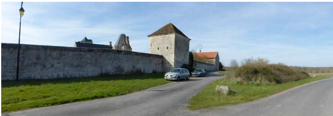
murs en pierres du château
