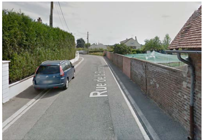
Mur en briques rouges (rue de la Bonnette)
