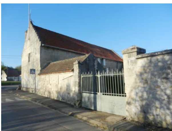
murs en pierres et pignons à redents (angle rue du château et place Hermine Guyot)
