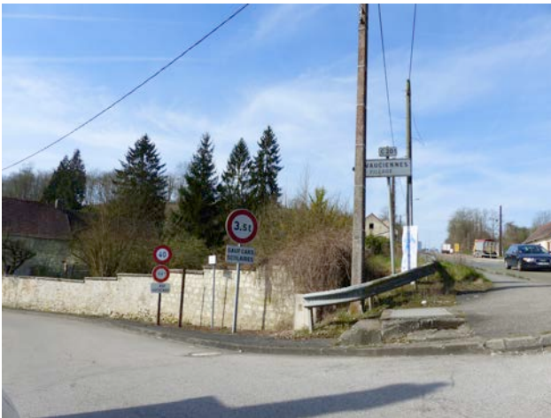
mur en pierres (angle de la rue de l'Église et de la RN2)
