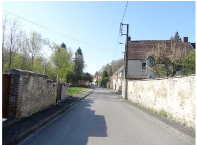
murs en pierres (rue de l'Église)
