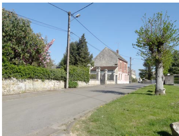
murs en pierres (14 et 12 rue du Château)
