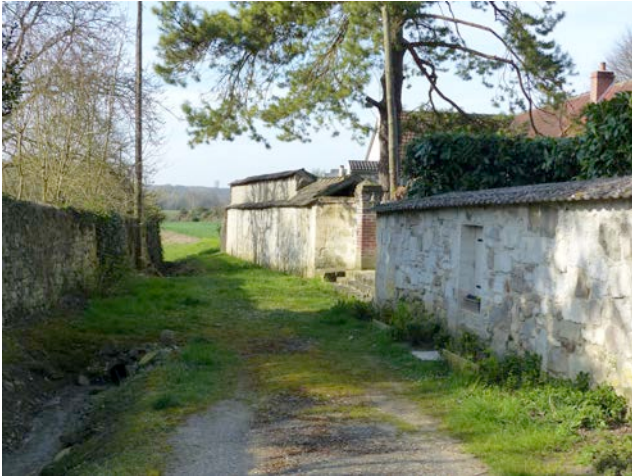
Murs en pierres
