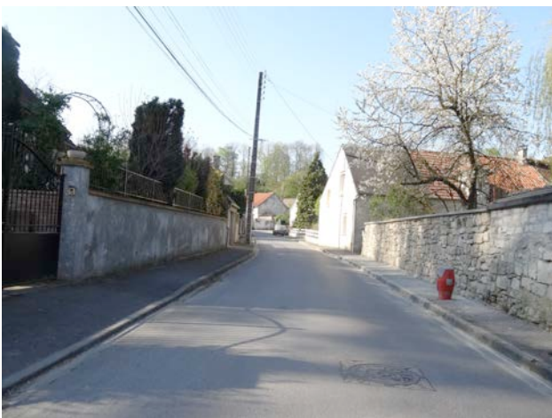
murs en pierres
