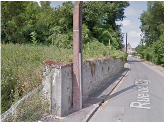
Mur en pierre (sud de la rue de l'Église)
