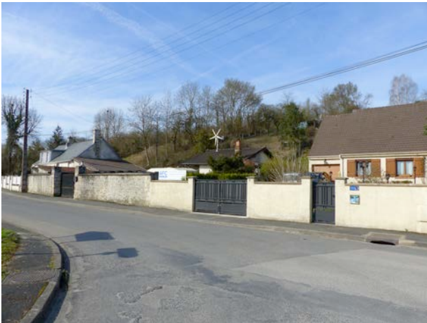
mur en pierres (rue de l'Église)
