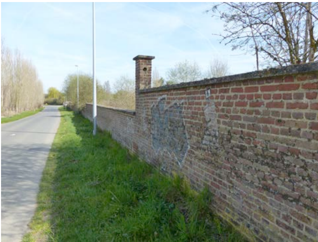
Mur en briques rouges (rue Guynemer)
