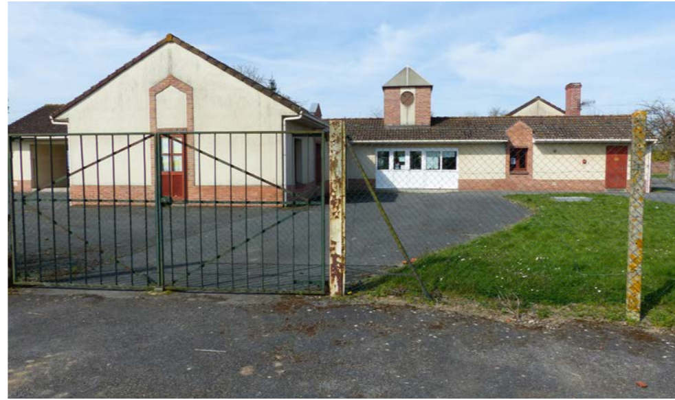
Vue sur le second bâtiment de l'école, par la rue de Varsovie.
