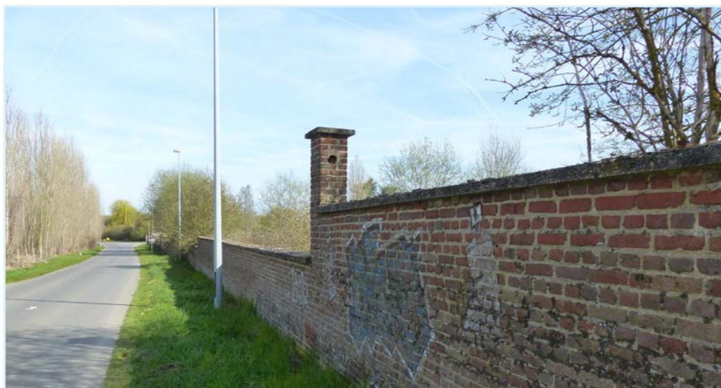
Vues sur la friche industrielle de Vauciennes, depuis la voie de contournement à l'ouest du village et depuis la rue Guynemer.
