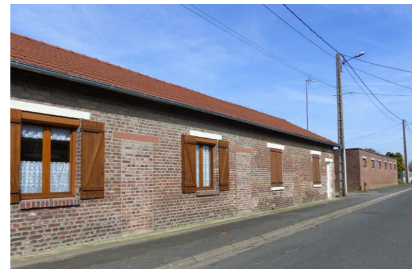
Le bâti ouvrier en briques rouges de type R+1 situé rue de la Bonnette.
