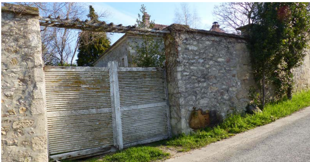
Linéaire de mur en pierres intéressant sur le hameau de Châvres.
