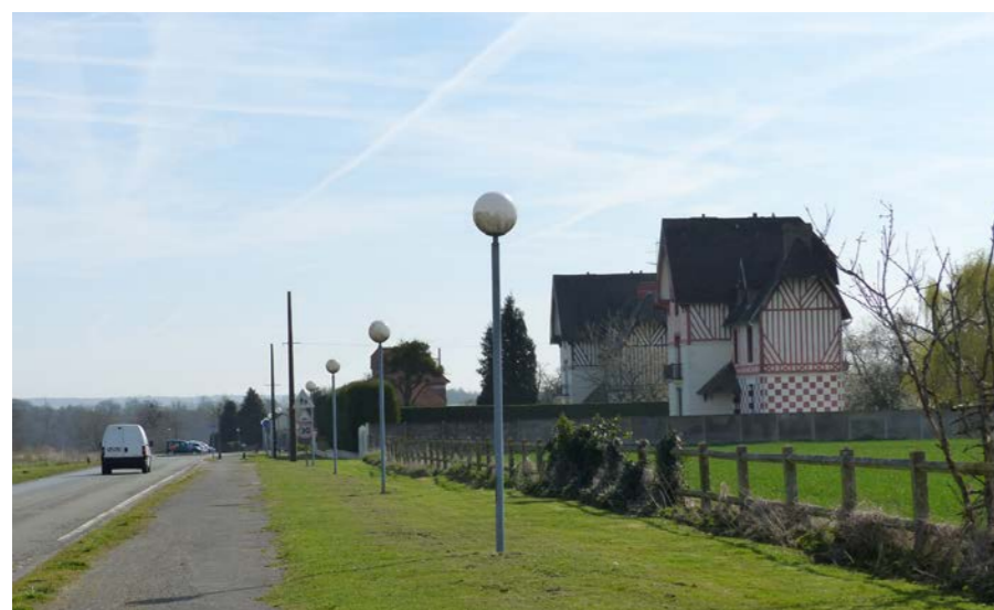
Les deux maisons bourgeoises situées sur la rue Guynemer.
