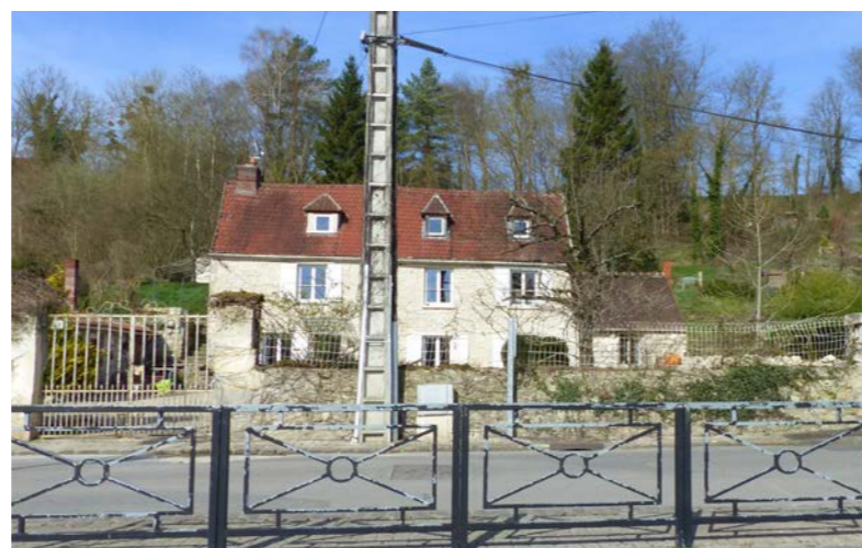
Construction de type ancien implantée en arrière de parcelles.
