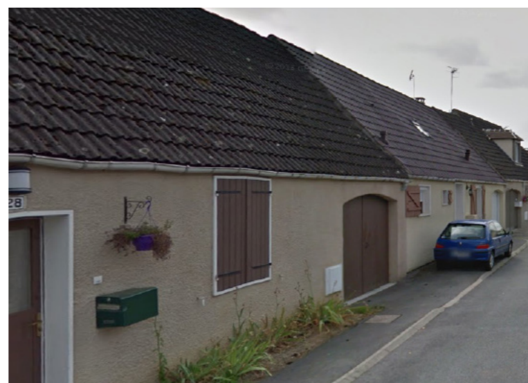
Maison R+C accolées et alignées sur la chaussée sur la rue des roses.
