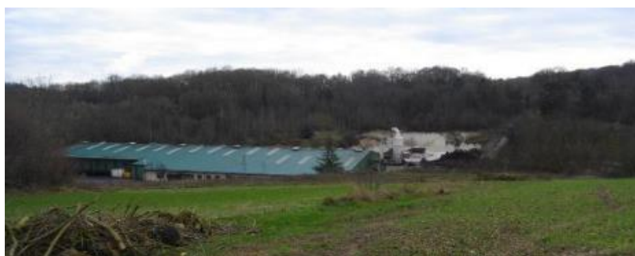
Figure 117 : Usine transform-Bois (rue de Senlis)
