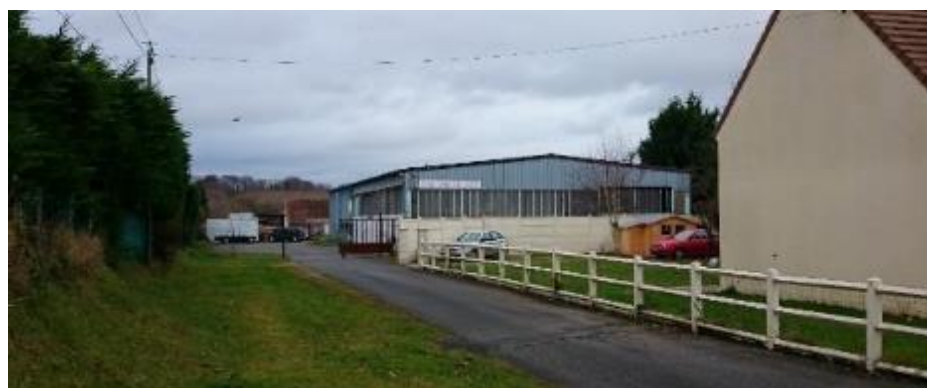
Figure 30 : Secteur artisanal rue de la croix du chêne
