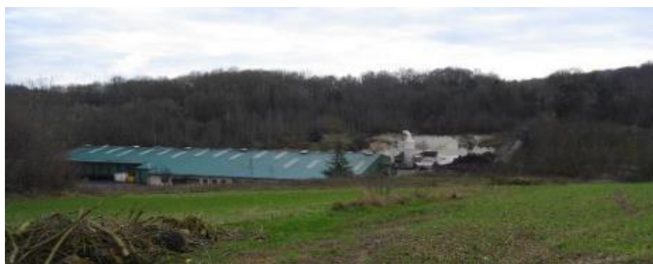
Figure 29 : Usine transform-Bois (rue de Senlis)
