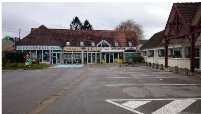
Figure 94 : Place commerçante de la Grande rue
