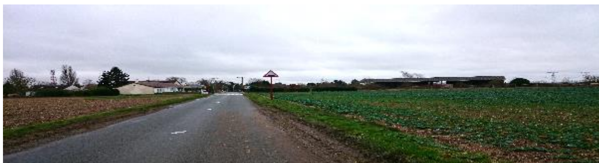
Figure 77 : Entrée du hameau de Cavillon sur la RD86 depuis le bourg
