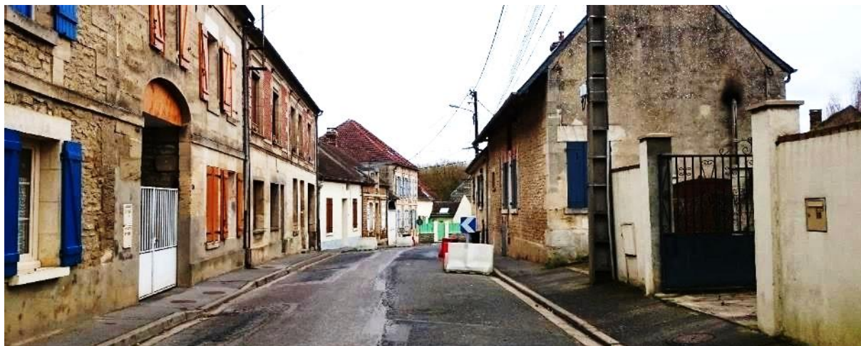
Figure 123 : Essais de chicanes rue de Mouy
