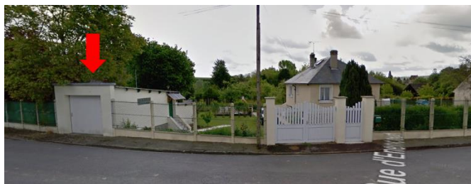
Figure 26: Implantation de l'annexe à l'alignement, devant l'habitation (rue d'Enencourt) - implantation non souhaitée dans le projet de PLU
