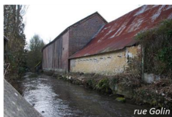
Ancien bâti à usage d’activité ●
