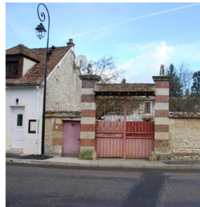
Figure 28: Porte charretière protégée, rue de l'Eglise
