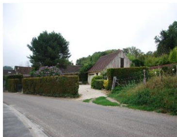
Annexe implantée à la sortie Est du village non raccordée au réseau d'assainissement des eaux usées
