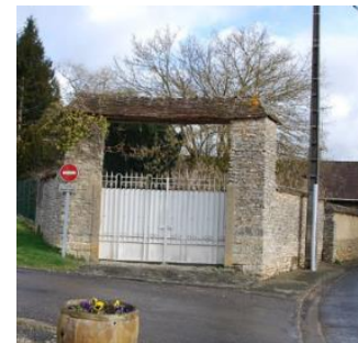
Figure 31: Porte charretière protégée, allée de l'Argillière
