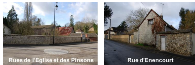
Figure 30: Les principaux murs anciens protégés (zone UD)
