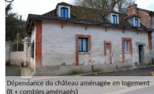
3 Vue D Dépendance du château aménagée en logement (R + combles aménagés)
