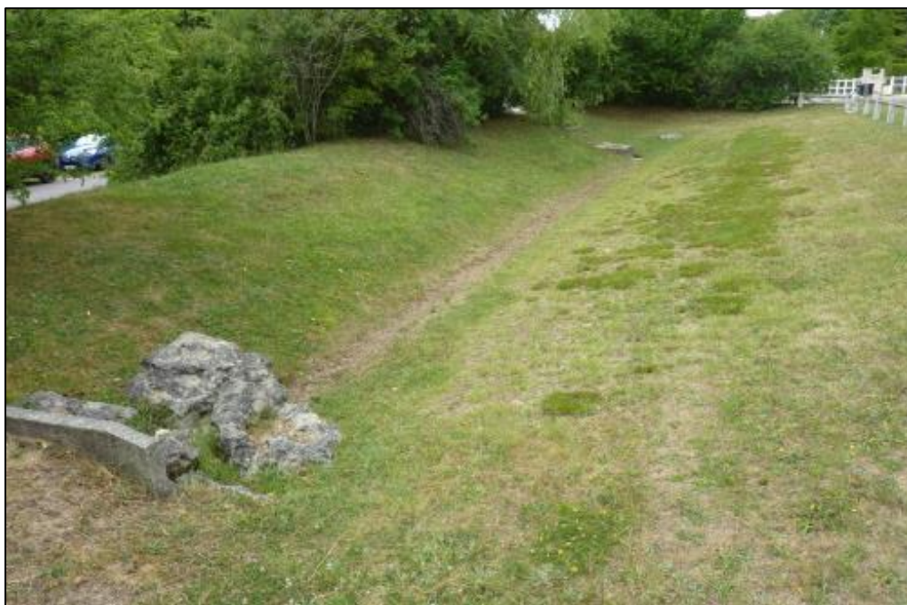
Figure 50. Photo du bassin 5
