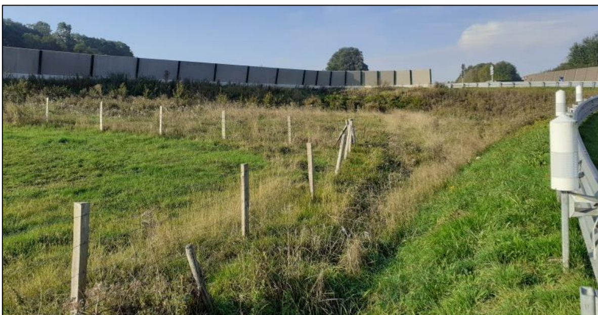
Figure 36. Fossé longeant les RD981 et RD166 à proximité du giratoire
