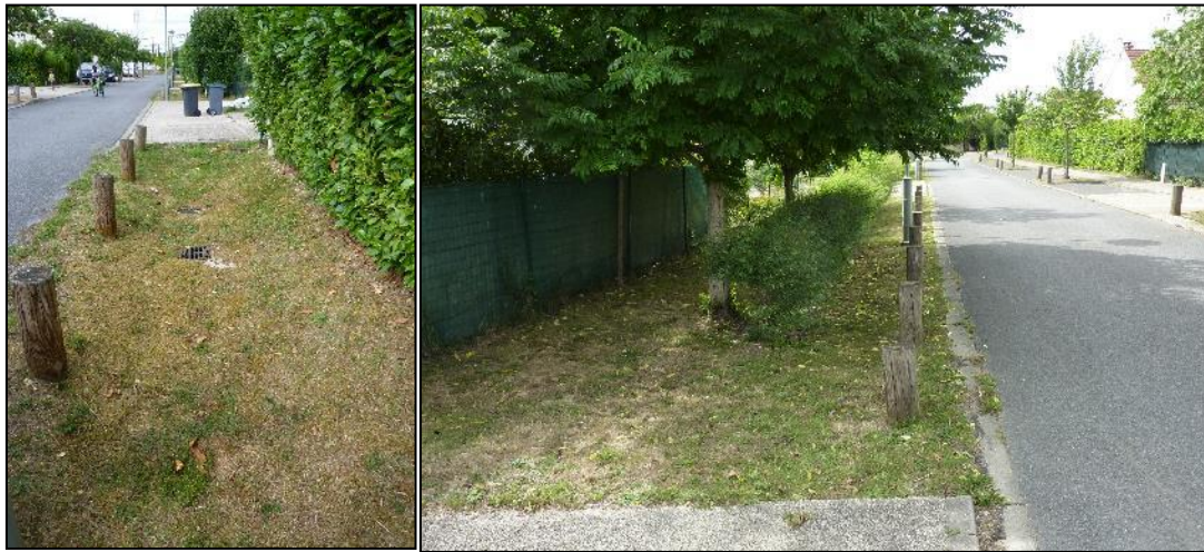
Figure 38. Rue Joseph le Caron (Fossé à gauche, Noue d'infiltration à droite)
