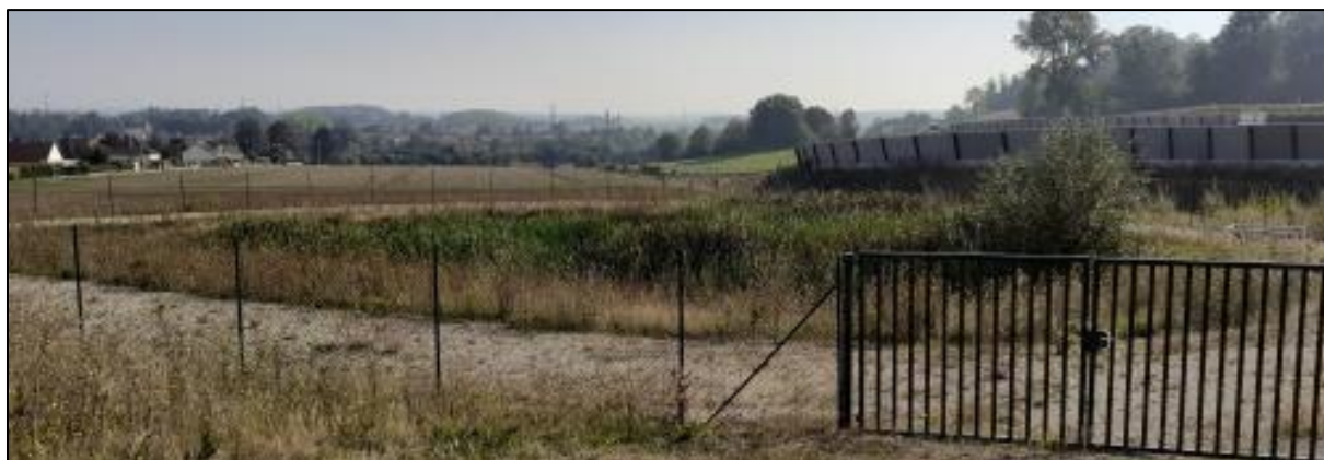
Figure 59. Photo du bassin 10
