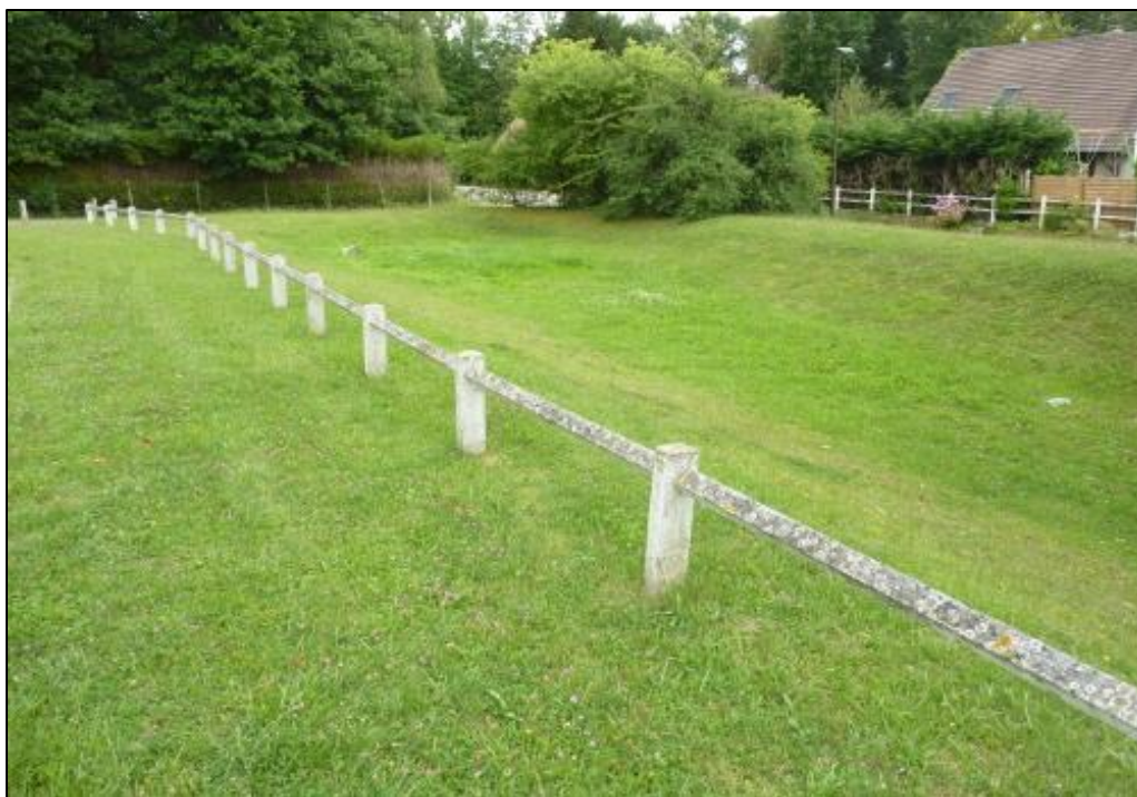
Figure 49. Photo du bassin 4
