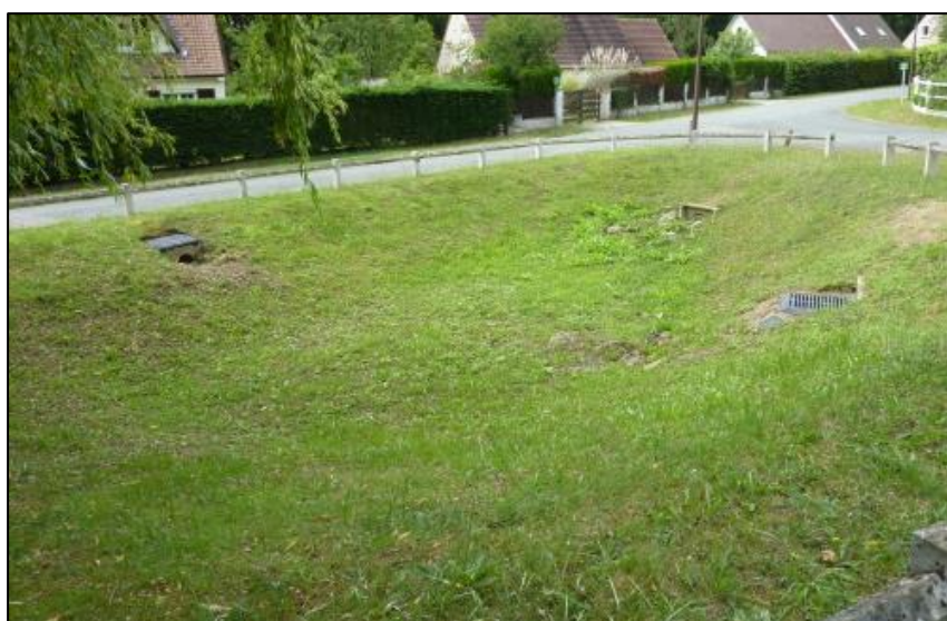
Figure 47. Photo du bassin 3
