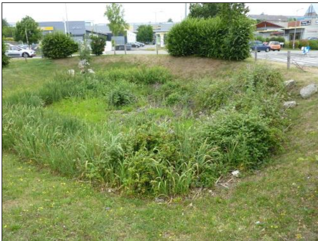
Figure 54. Photo du bassin 7
