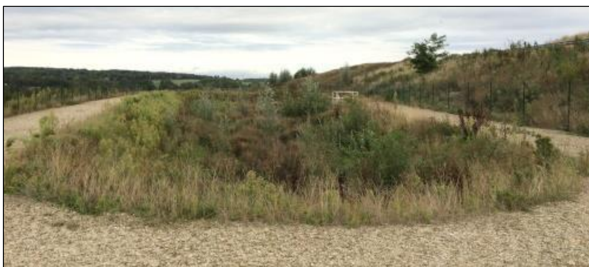
Figure 57. Photo du bassin 9
