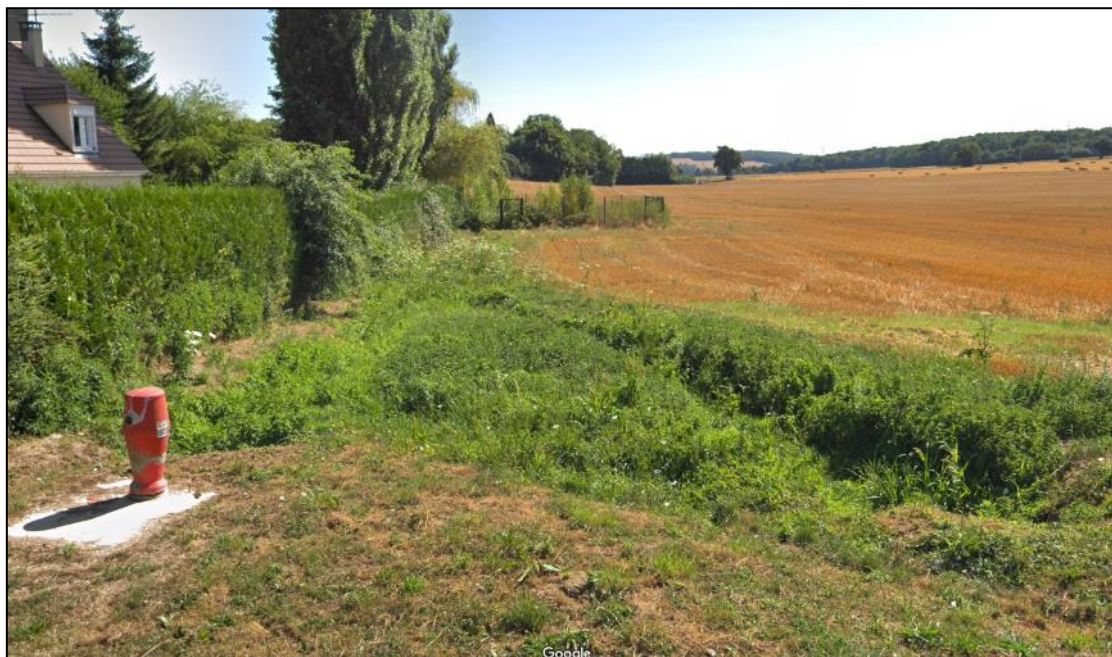
Figure 39. Fossés au sud de la Rue des Gauguettes (Partie aval)
