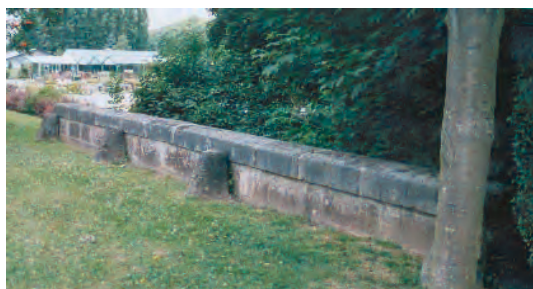
1. Pont sur l'Arré à St-Just
