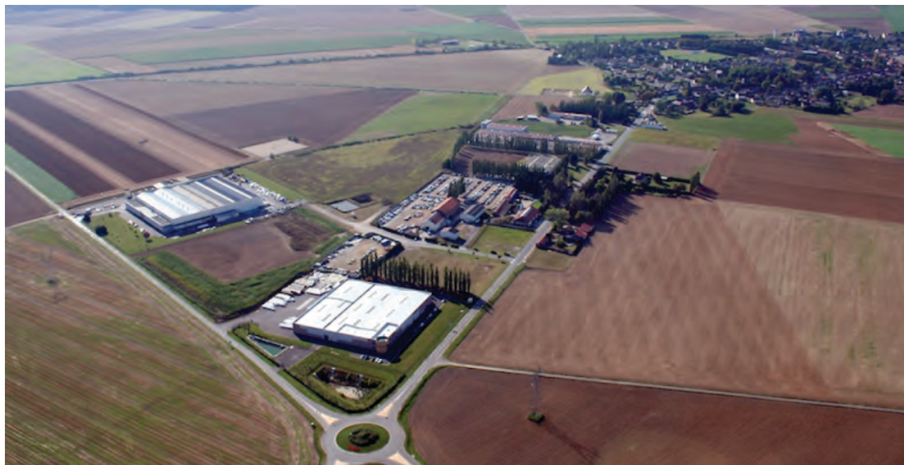
Vue sur la zone industrielle et zone artisanale de Tricot, de compétence intercommunale
