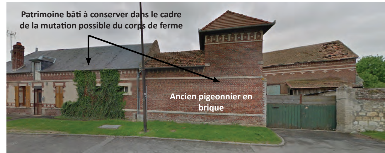
Vue sur le corps de ferme de la rue Saint-Antoine (depuis la rue Saint-Antoine)
