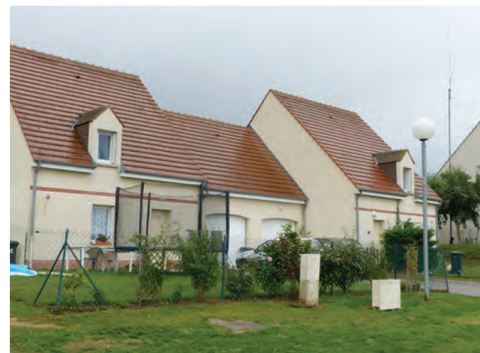
Logements individuels groupés de la rue Brûlée
