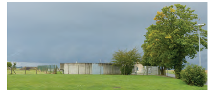
Station d'épuration de Tricot située à l'écart du bourg
