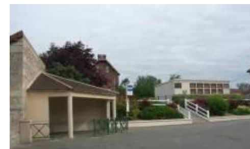
Abribus situé sur la place centrale
