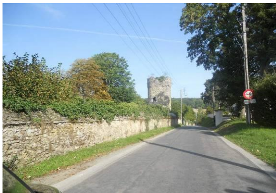
Continuité visuelle due aux murs en moellons
