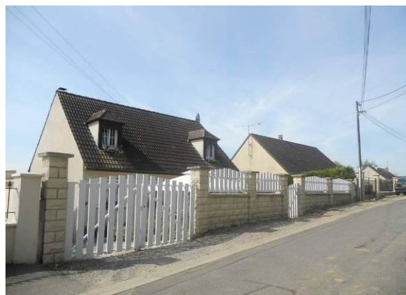
Continuité visuelle de la rue due aux clôtures basses
