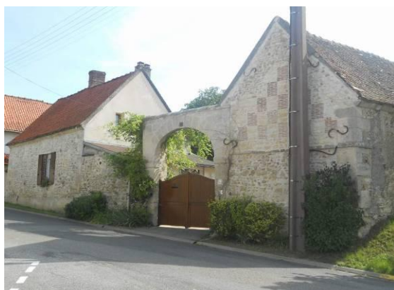
Ancien corps de ferme en moellons apparents
