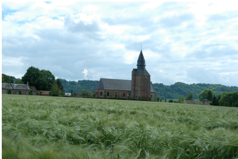
Point de vue remarquable sur l'église de Silly-Tillard préservé par les dispositions du PLU.
