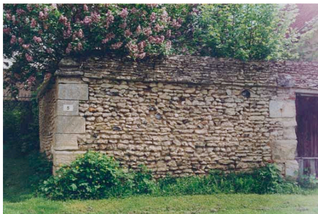
Un mur de clôture remarquable réalisé en moellon
