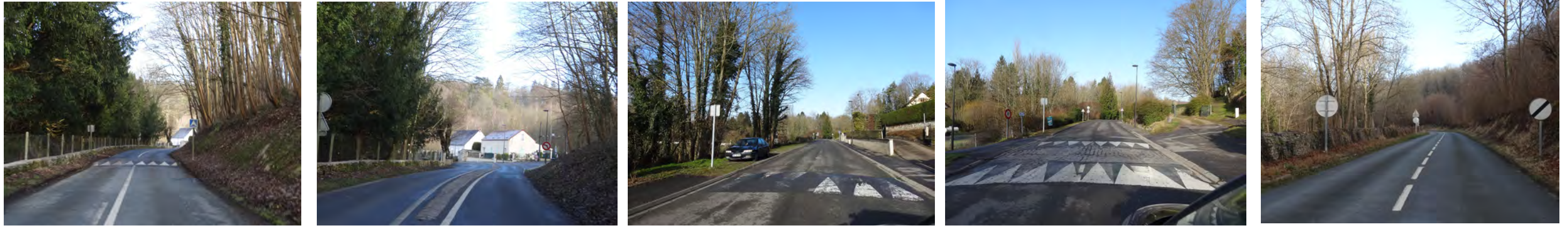
La traversée du bourg de Séry a fait l'objet d'aménagements visant à réduire la vitesse des véhicules (ralentisseurs, terre-pleins et signalisation )
