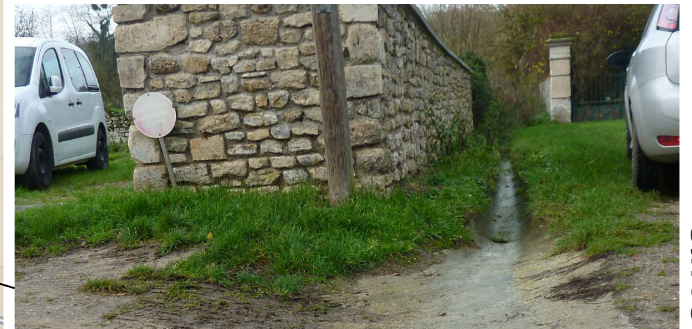
Gestion du ruissellement à travers Magneval : axe gravitaire qui collecte le ruissellement de la rue des Collinières.
