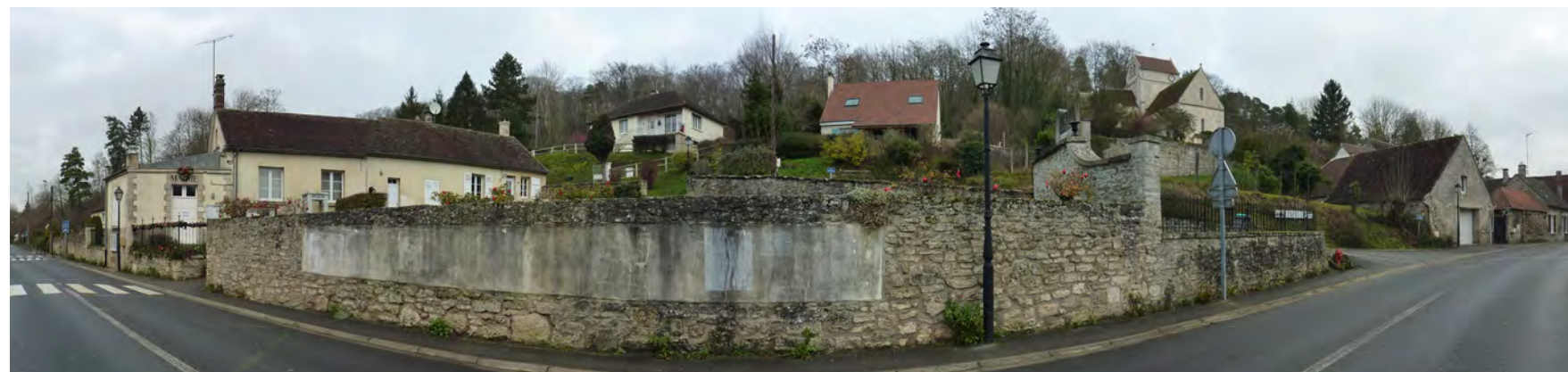
Mur de clôture traditionnel en pierre moellons autour de l'espace public de la mairie.
