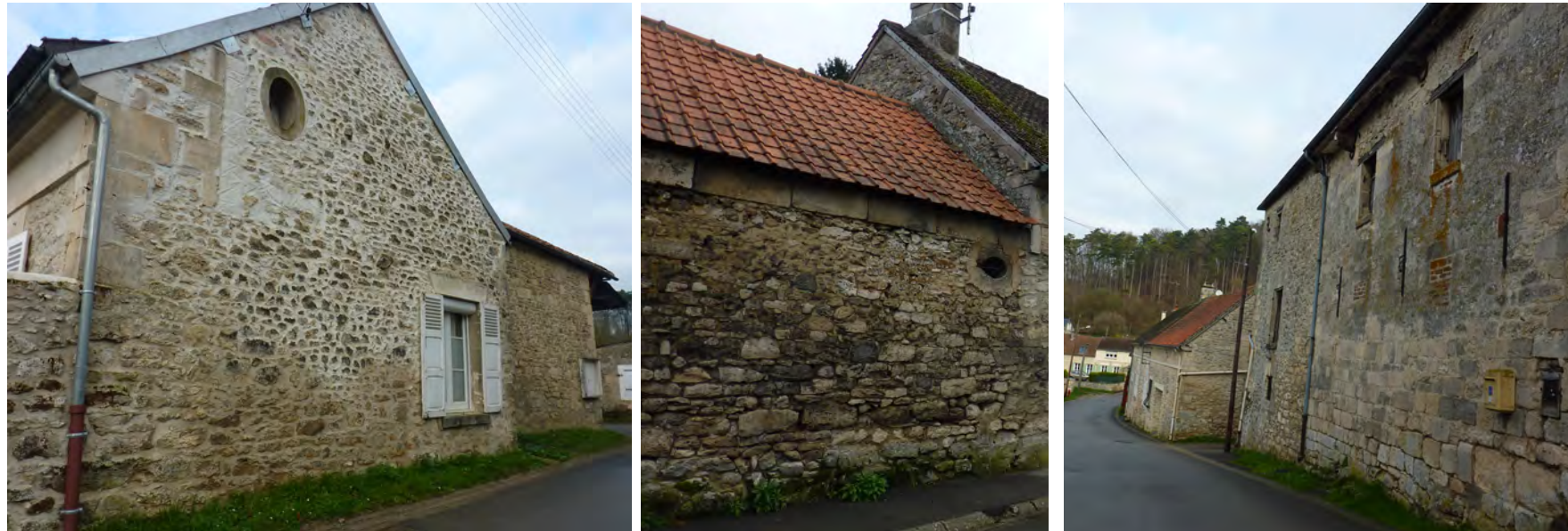
Pignon de façade en moellons gris et brun à joint beurré à Magneval ; Mur de façade en moellons de grès dans les tons ocre rue Robert Ruegg à Séry et façade d'une ferme à Magneval alternant pierres de taille et moellons apparents.
