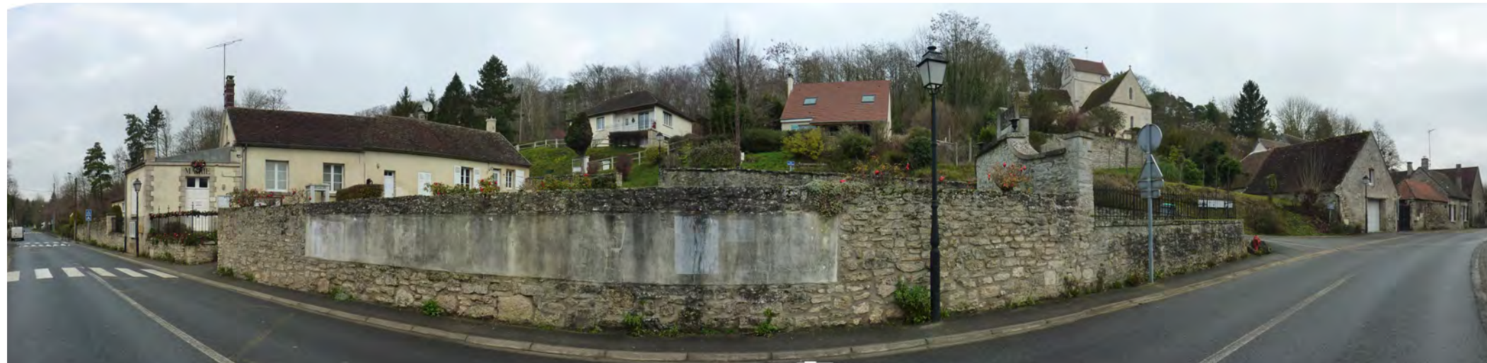
Point de vue depuis la rue Robert Ruegg sur l'Eglise Saint-Pierre et Saint-Michel
