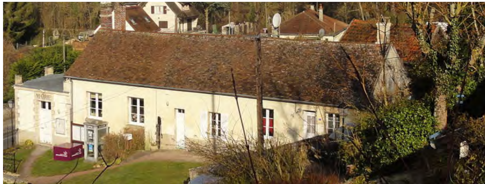
La mairie de Séry-Magneval : une toiture caractéristique du bâti ancien sur la commune.
