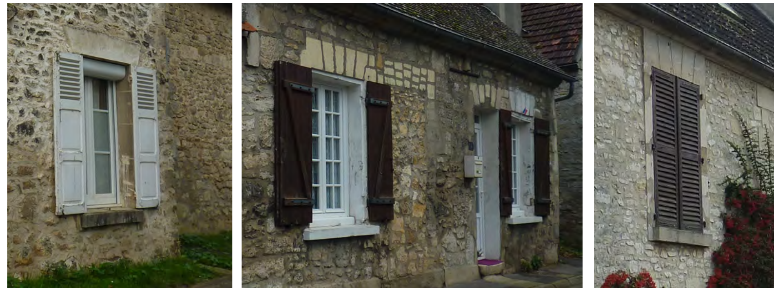
Les ouvertures des façades anciennes ont un format standard avec une hauteur qui représente 1,5 fois la largeur. Les linteaux sont généralement en pierres de taille. Les menuiseries en bois sont peintes : blanc, couleur bois, rouge ou vert foncé.
