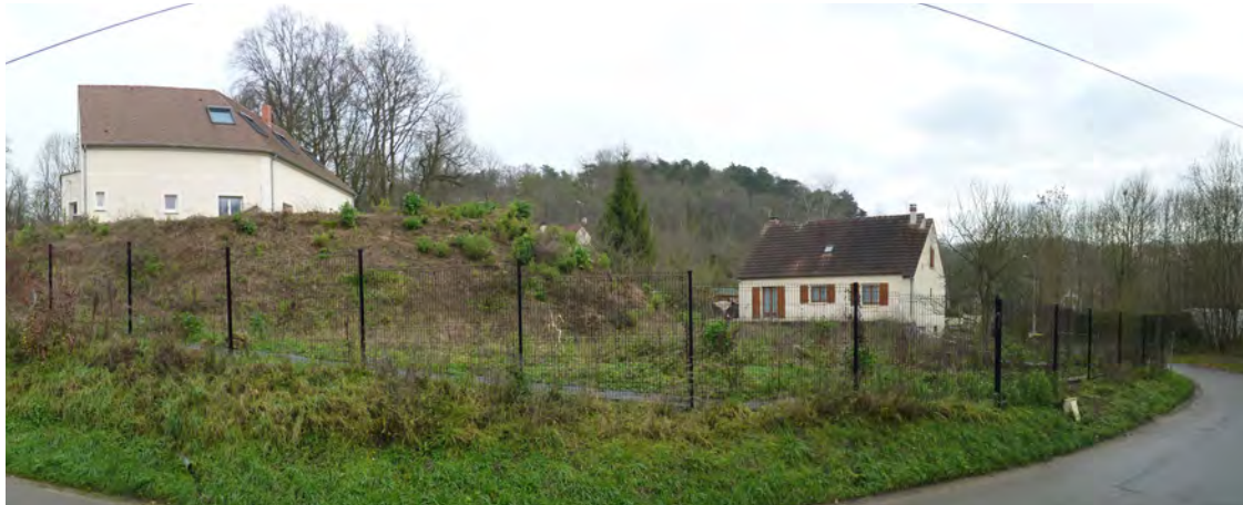
Pavillon récent rue des Collinières construit à proximité d'une zone humide nécessitant un remblais ayant un impact important sur le paysage.
