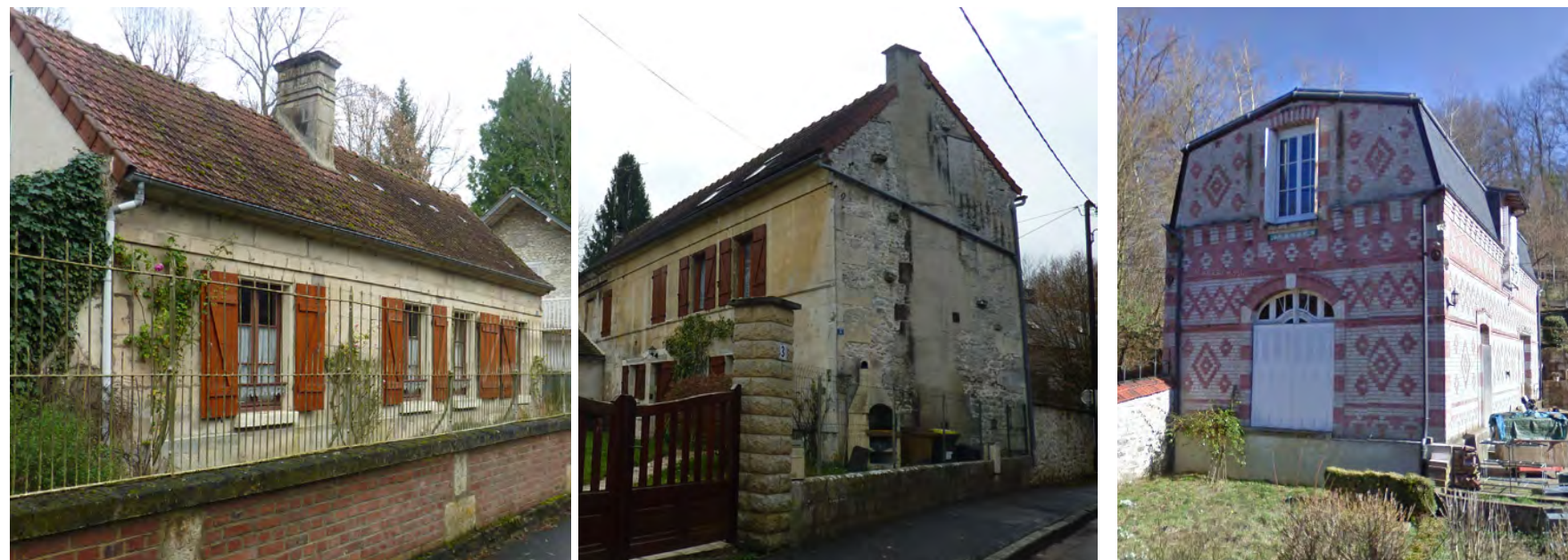
Maison rurale chemin des Dîmes en pierres de taille avec corniche ; Maison de village enduite rue d'Orléans et maison de village rue Robert Ruegg (entre Séry et Magneval) avec façade ornementée alternant par des motifs géométriques entre la pierre et la brique rose.
