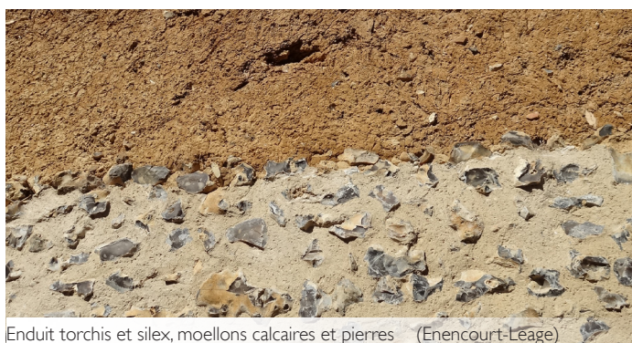
Enduit torchis et silex, moellons calcaires et pierres (Enencourt-Léage)
