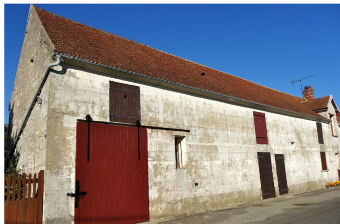
Portes coulissantes pour un usage pratique (Liancourt-St-Pierre)
