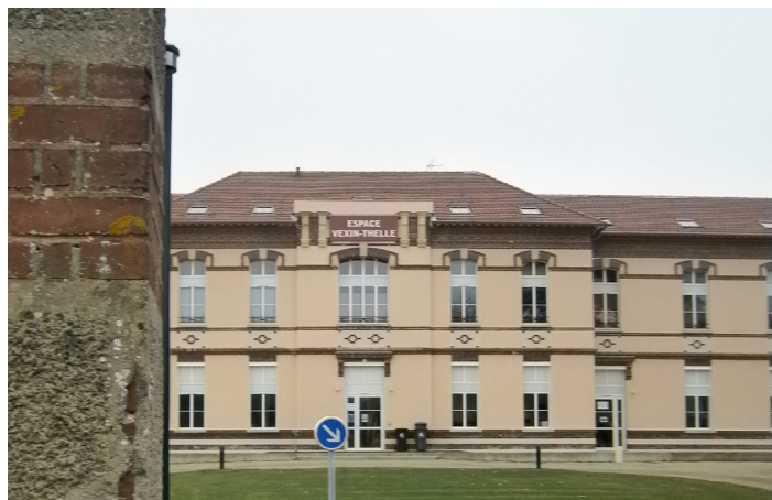
Reconversion d'un équipement public
