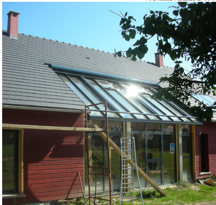
Création d'une verrière dans un volume traditionnel
