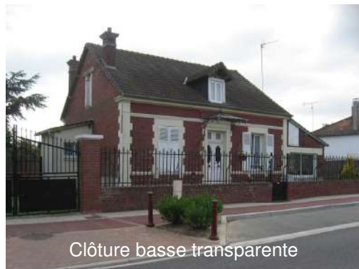
Toiture à 4 pans recouverte de tuiles grises plates
