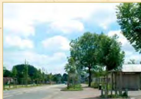
Réalisation d'un projet de traversée d'agglomération
