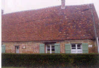
toiture couverte en tuile plate
