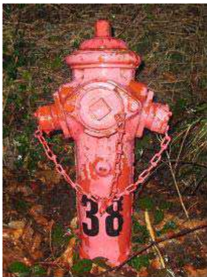
P I de 80 mm avec une sortie de 65 mm et deux sorties de 40 mm
