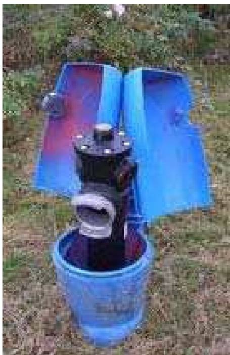
Principe d'implantation d'un poteau d'aspiration à réseau sec
