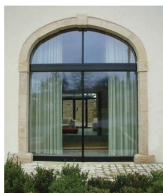
Porte vitrée – Arc cintrée
