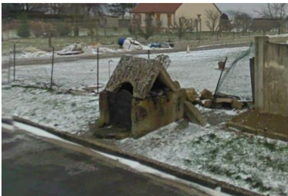
Puits rue du Général Leclerc
