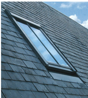
Châssis de toiture classique (type velux), encastré dans le plan de toiture avec meneau rapporté.
