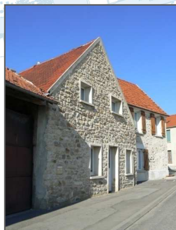
Façade est en pierres de taille calcaires
