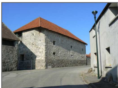
Corps de ferme rénové présentant un toit en croupe
