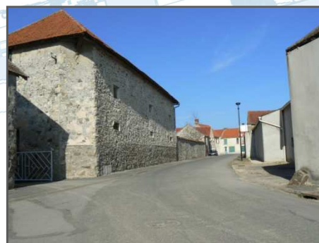
Constructions dont la façade est alignée par rapport à la voie publique
