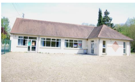
parking de la salle péri-scolaire
