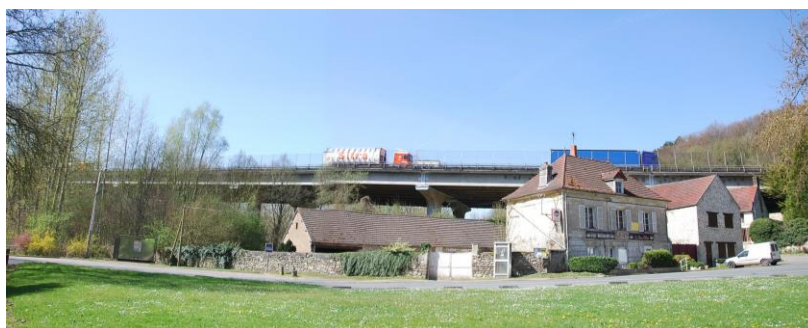
Figure 30 : L'autoroute surplombe le bâti
