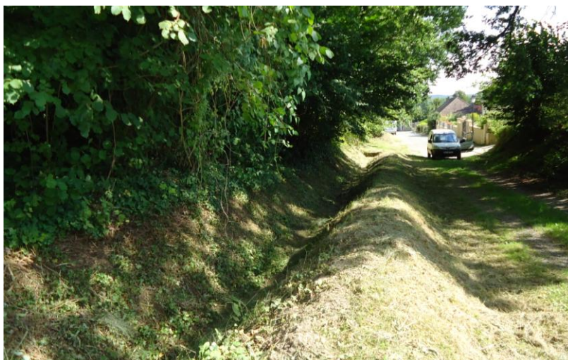
Figure 17. Fossé situé au début de la rue de la Fontaine, au niveau de la Montagne.
