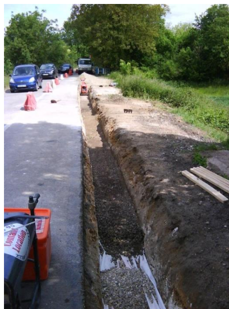
Figure 35. Photographie représentant une tranchée de pose de canalisation
