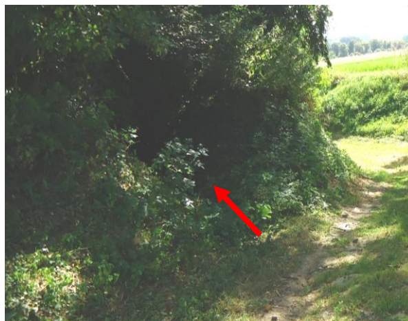
Figure 18. Saignée située le long de le chemin de la Cavée du Moulin
