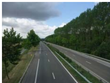
Vue Ouest de la RD200 depuis le pont
