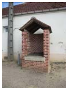
Le puits, situé rue de la République, est rebouché, pour des questions de sécurité
