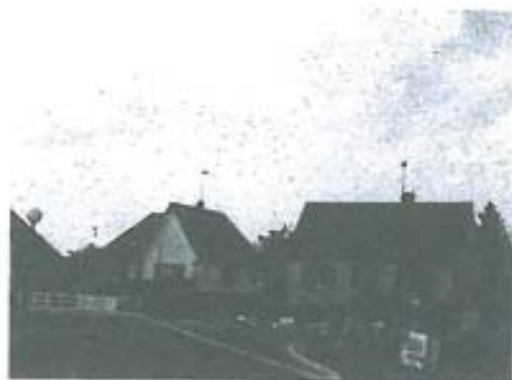
Maison à un seul niveau
