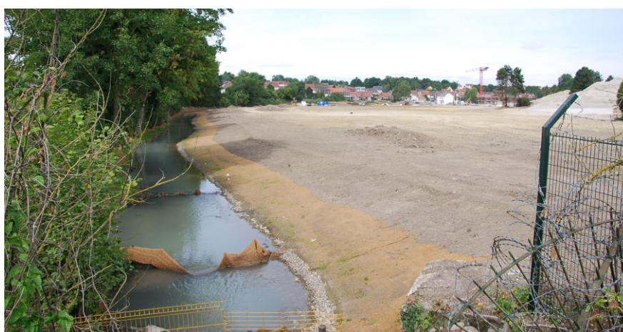
Figure 17 : Site de la friche après démolition des constructions
