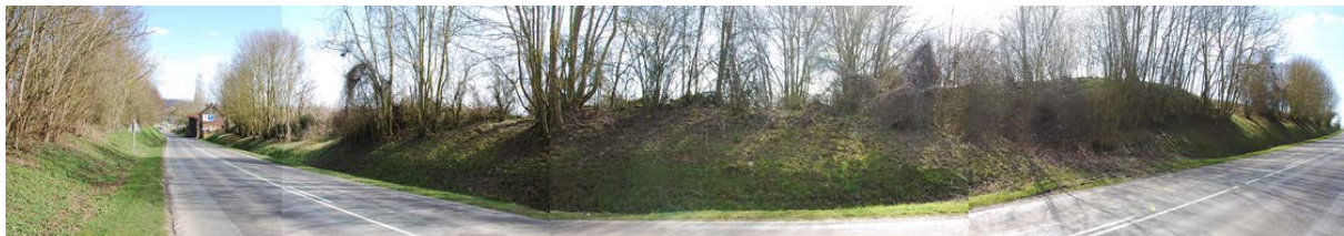
Figure 11: Façade du terrain accueillant la nouvelle plateforme logistique (RD82)
