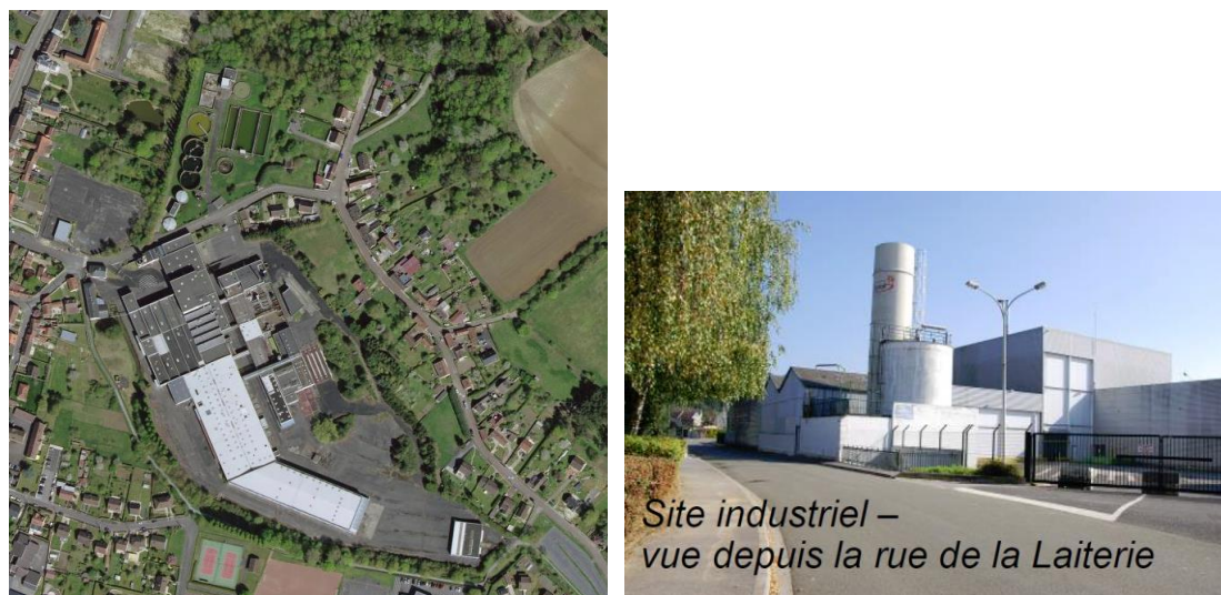
Figure 16 : Site industriel "Yoplait" à l'origine
