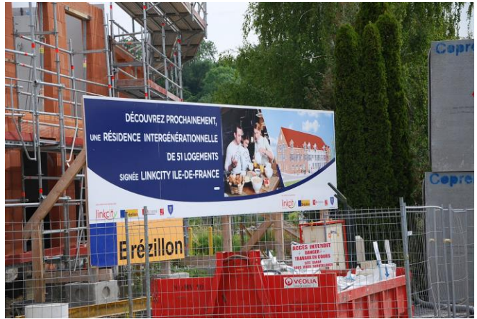
Figure 5 : Le projet en cours de construction
